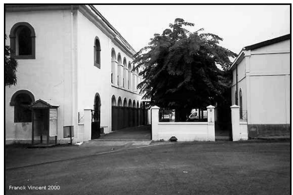
L'hôpital (façade côté cour ; l'autre façade possède un étage inférieur constitué de « magasins »). Photo F.VINCENT, 2000. Dans sa thèse de médecine, le Docteur GRENET remarque que par l'étroitesse de sa cour et sa disposition, il s'agit véritablement d'un hôpital de forteresse.
